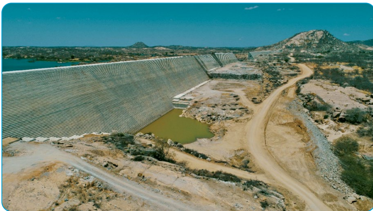
Barragem de Oitica em fase final de construção
