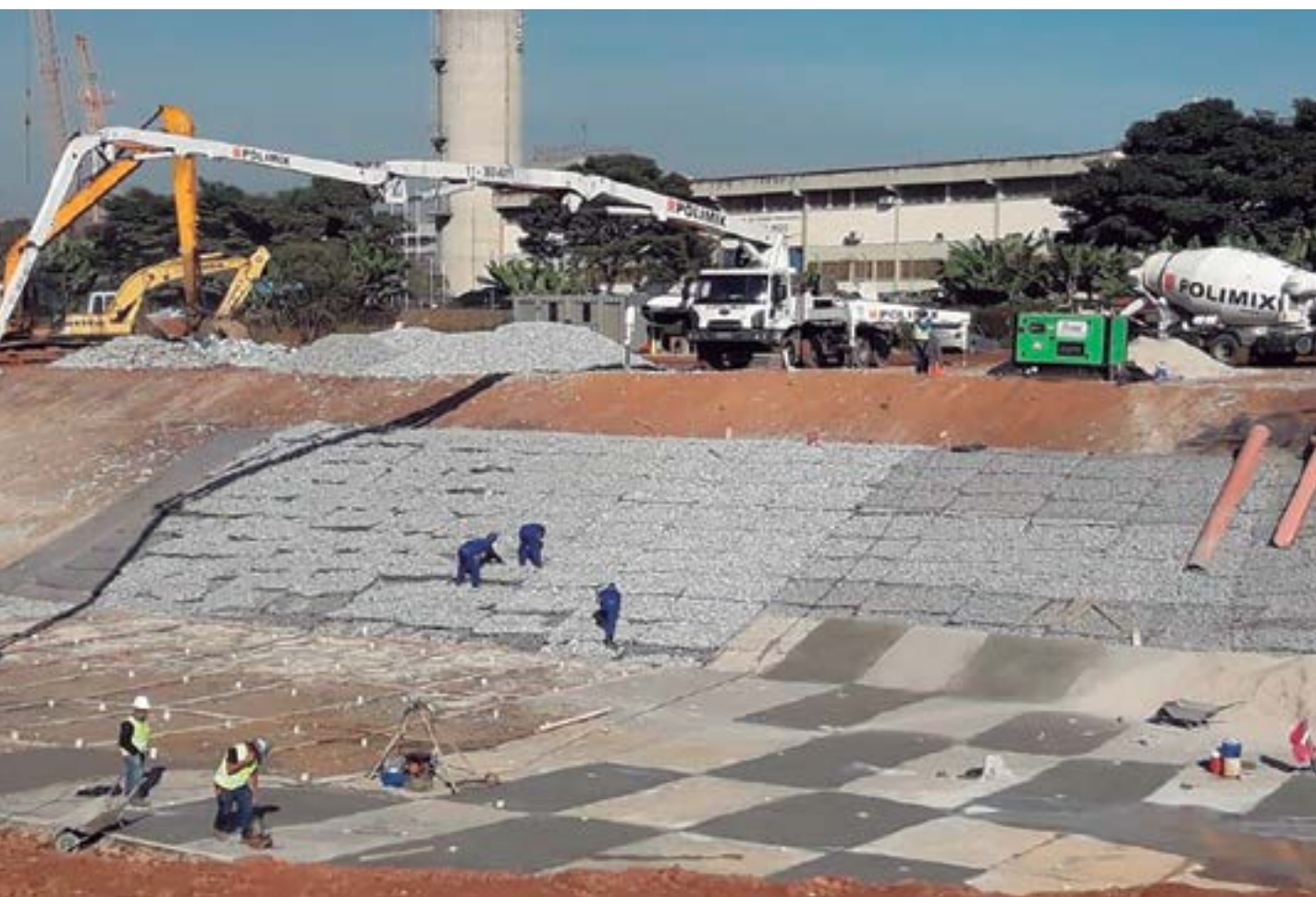
Canalização do Rio Baquirivu.
