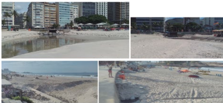
Figura 7 – Fotos do cinturão sanitário das praias de Copacabana e Ipanema, em dois momentos (um extravasando após fortes chuvas e outro já fechado sem extravaso).
