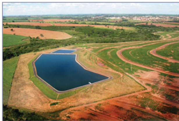
Sistema de Tratamento de Esgoto por Lagoas de Estabilização executado na cidade de Urupês. Lagoa Anaeróbia seguida de Lagoa Facultativa. Investimento de R$ 1 milhão de reais – População beneficiada 12 mil habitantes
