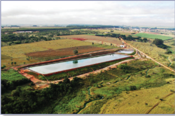
Sistema de Tratamento de Esgoto por Lagoas de Estabilização executado na cidade de Guaíçara. Lagoa Anaeróbia seguida de Lagoa Facultativa. Investimento de R$ 1,35 milhões de reais – População beneficiada 15 mil habitantes
