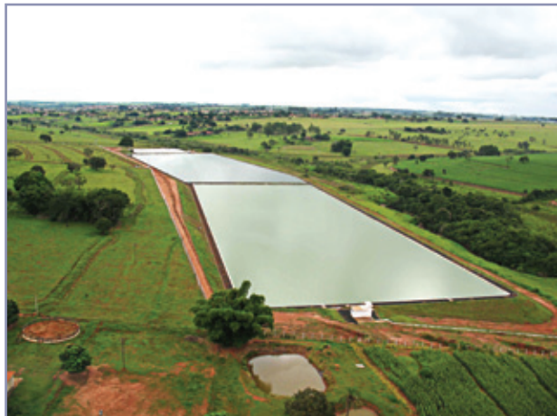
Sistema de Tratamento de Esgoto por Lagoas de Estabilização executado na cidade de Tanabi. Lagoa Anaeróbia seguida de Lagoas Facultativas. Investimento de R$ 1,55 milhões de reais – População beneficiada 22 mil habitantes
