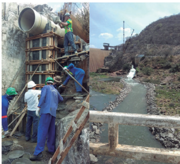
Figura 07 – Adequação de Barrilete no Reservatório de Mãe D' Água
