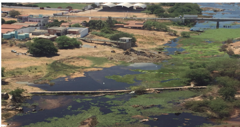
Figura 03 - Sacaria de areia - Fonte: O autor
