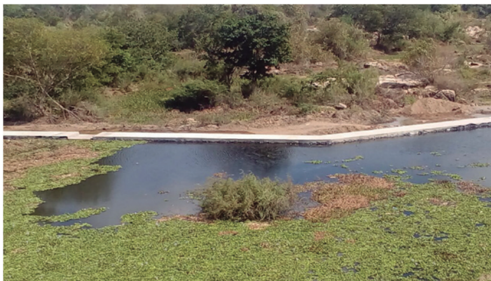
Figura 04 - Sacaria de areia revestida com alvenaria - Fonte: O autor
