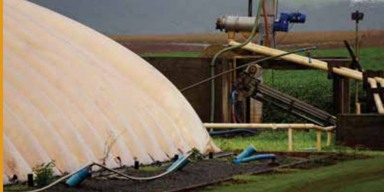
Biogás produzido na Granja Haack é refinado para virar biometano, que é usado como combustível automotivo. Fotos: Adenésio Zanella
