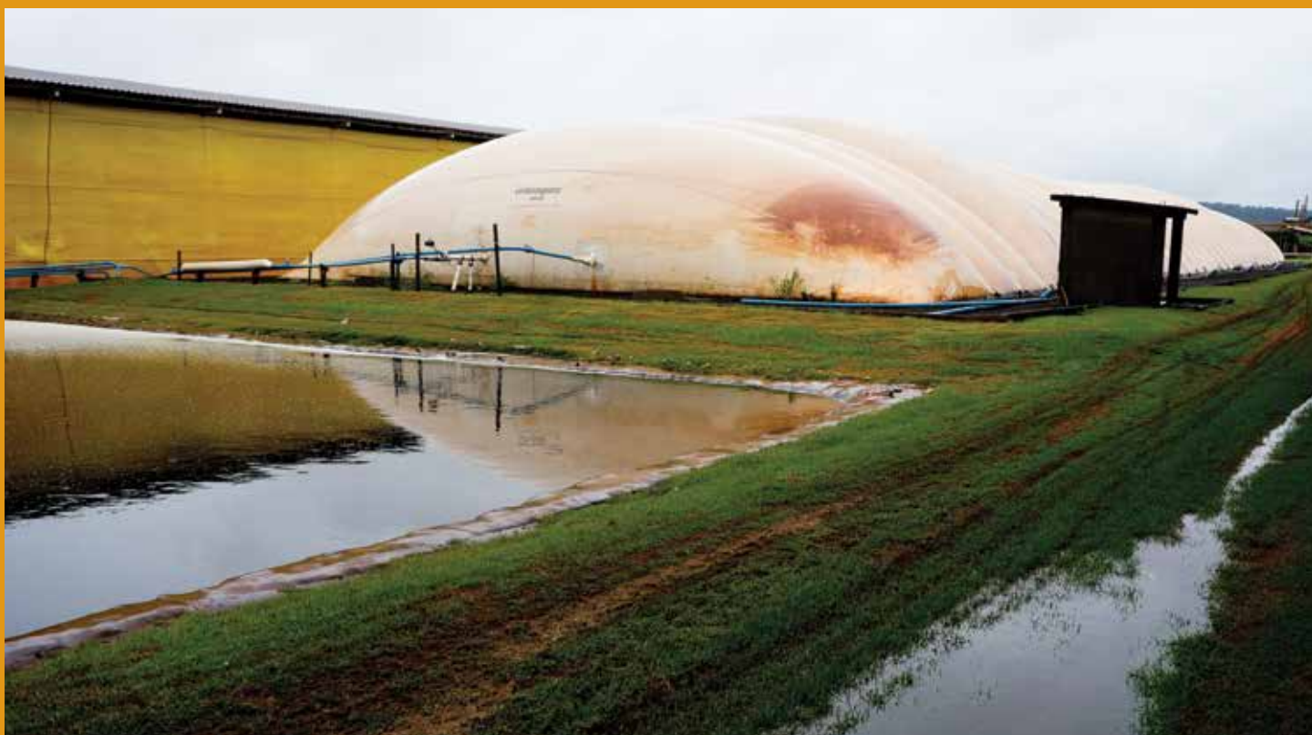
Biogás produzido na Granja Haack é refinado para virar biometano, que é usado como combustível automotivo. Fotos: Adenésio Zanella
