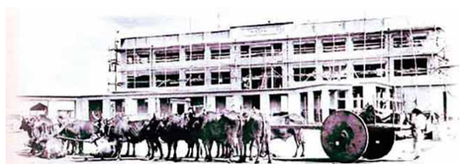
Construção de Goiânia, destaque para o Palácio das Esmeraldas, em 1940.
