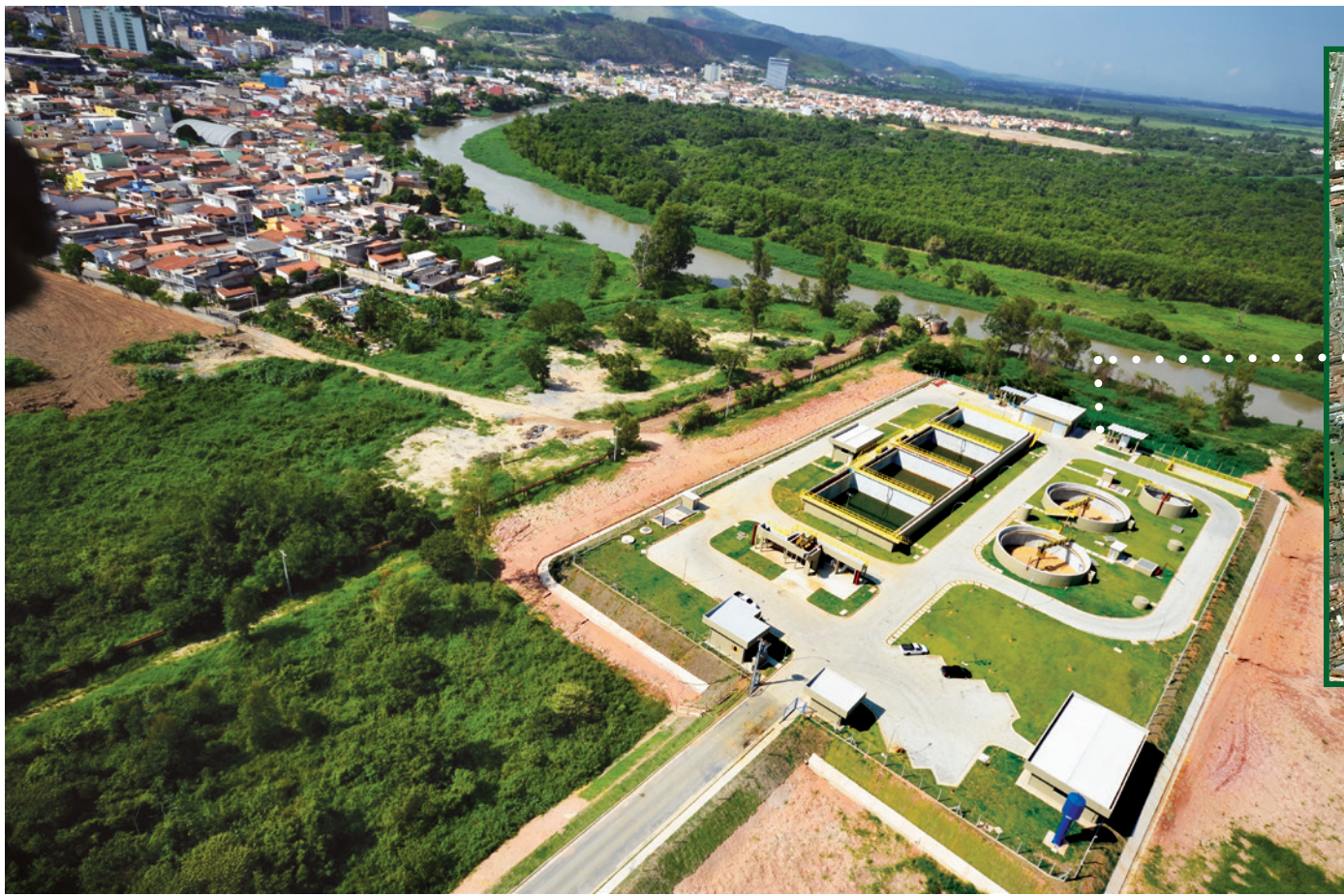
Aparecida, São Paulo ETE por Lodo Ativado por Aeração Prolongada
