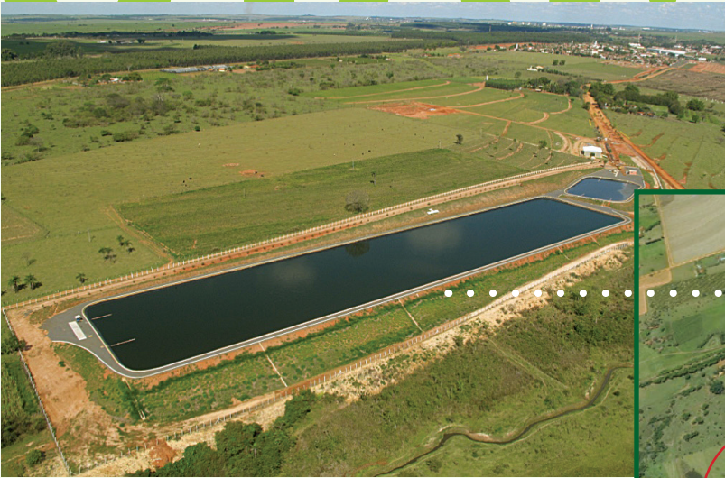
Guaiçara, São Paulo Tratamento de Esgoto por Lagoas de Estabilização
