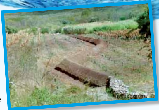
Detalhe do Canal de Retenção d'água de um Cordão de Pedra próximo do Rio Cangati em Canindé-CE
